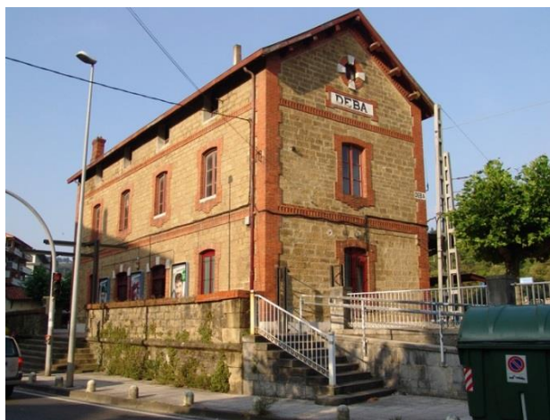
Edificio de la estación del Ferrocarril Vascongado, Deba – Camino de Santiago (Fuente: Debako Udala)
