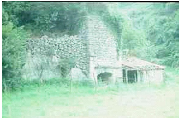
Calero de Astigarribia, margen izquierda del río Deba (Mutriku) (Fuente: Diputación Foral de Gipuzkoa)
