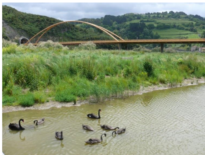
Puente de la carretera GI-638 sobre el río Deba desde el meandro con el barrio de Artzabal en la margen derecha
